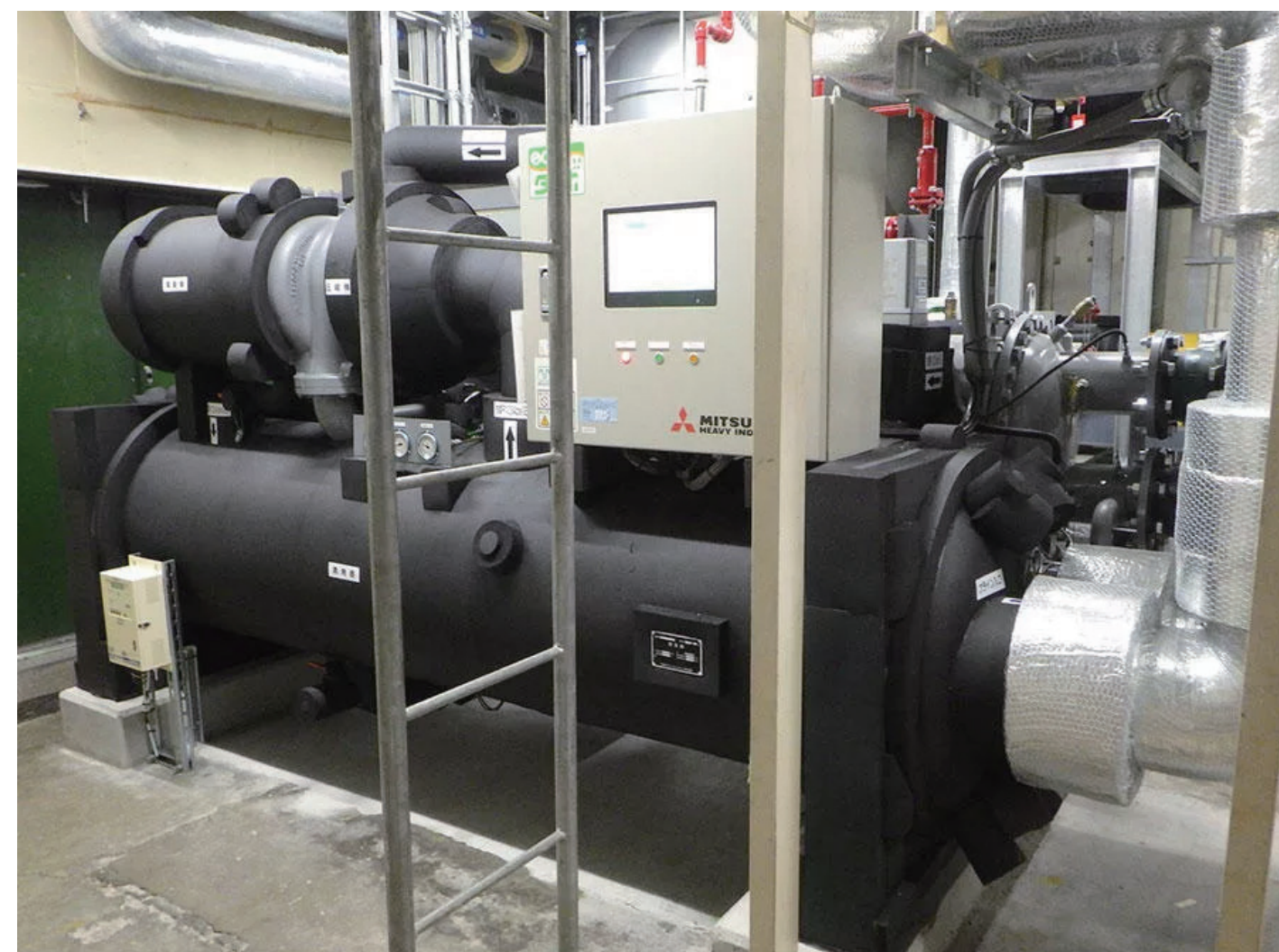
低GWP冷媒 採用 インバータターボ冷凍機 ETI-ZE25
