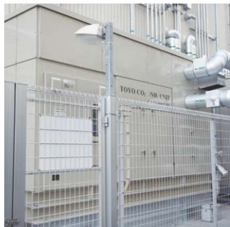
CO 2 /NH 3 二次冷媒CO 2 液循環方式製氷装置
