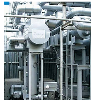
高効率CO 2 /NH 3 カスケード二元冷凍システム [ネスレジャパン マニファクチャリング(株) 姫路工場]
