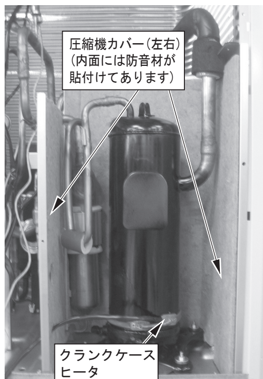
⑤圧縮機配線、圧縮機カバー(左右)およびクランクケースヒータを外してください。
