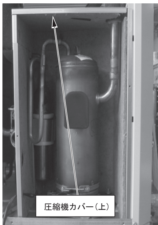
④圧縮機カバー(上)を取外してください。
