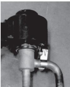
・室内膨張弁コイル抜け
