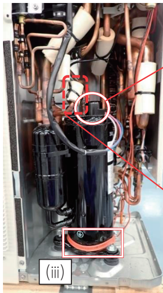
図 1 圧縮機の吸音材取外し
