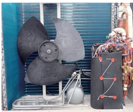
(c)バッフルプレート取外し後
