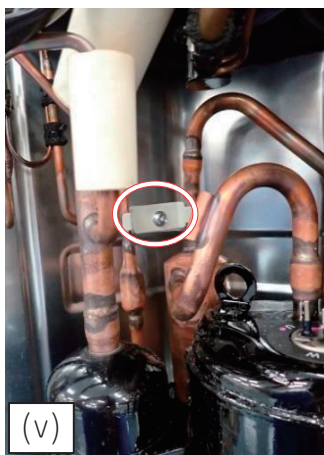
図 2 圧縮機周辺部品の取外し
