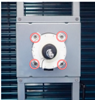
図3 室外ファンモータ取外し
