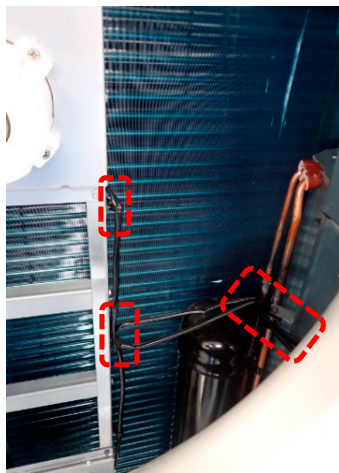
図2 コネクタ、配線固定箇所取外し
